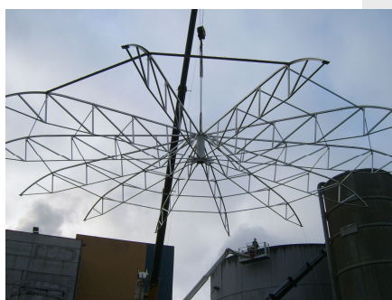
Couvertures de bassins (contrôle des odeurs)
